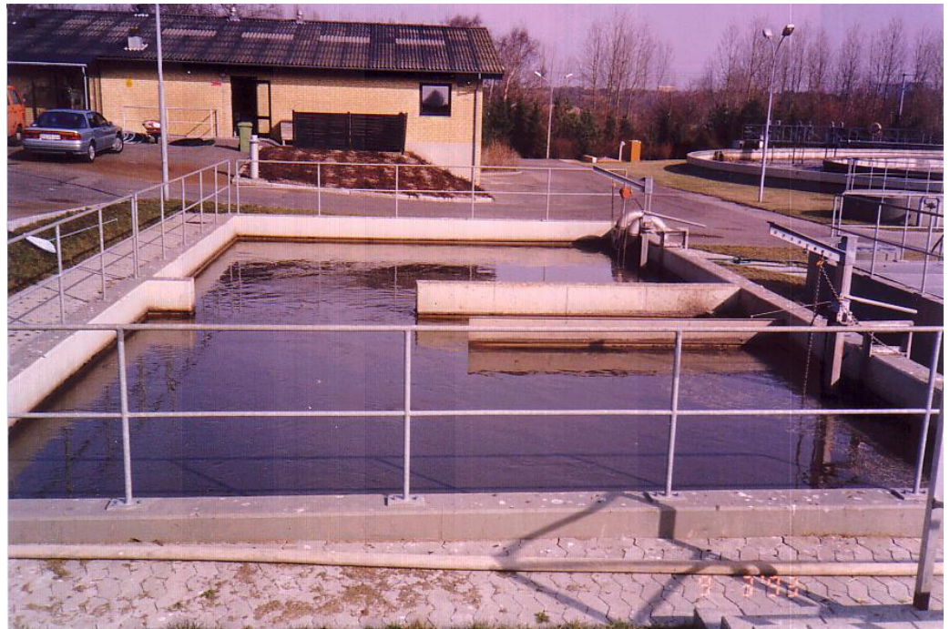
Anaerob fortank til biologisk fosforfjernelse. Stenløse rensningsanlæg
