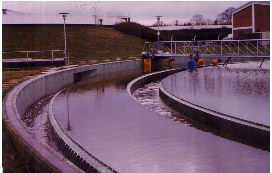
Sekundær bundfældningstank
