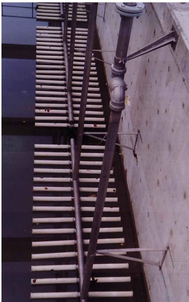
Keramiske diffusorer til luftning af aktivslam
