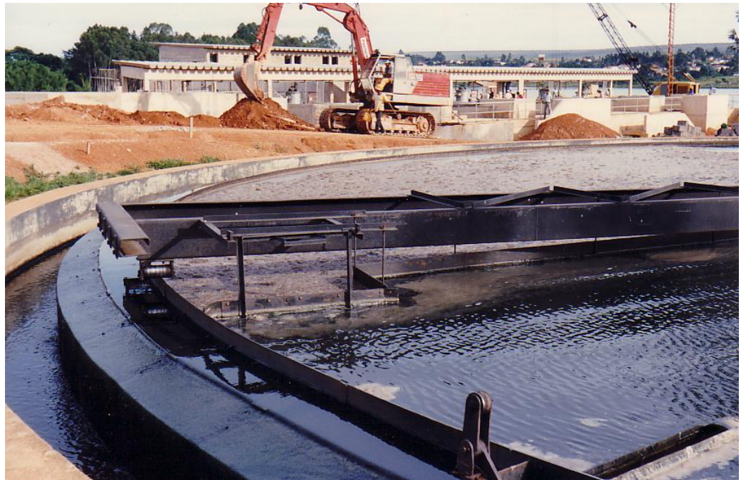
Flydeslam på sekundær bundfældningstank. Nocardiaslum, også kaldet chokolademousse
