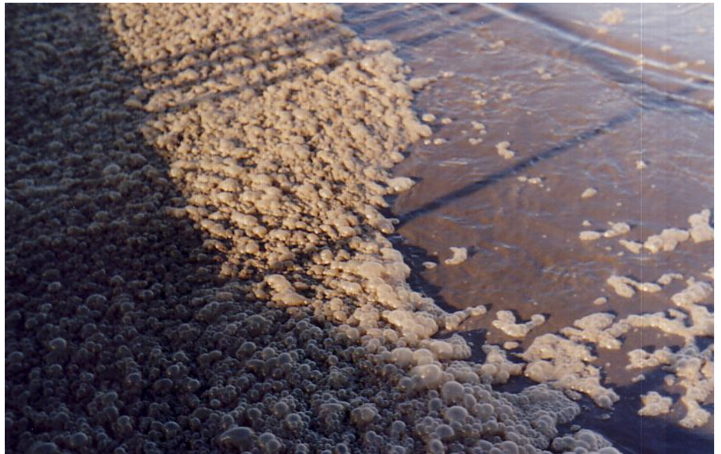
Skum i aktivtanke kan være mange ting. Her ses skum af denitrifikationsbobler
