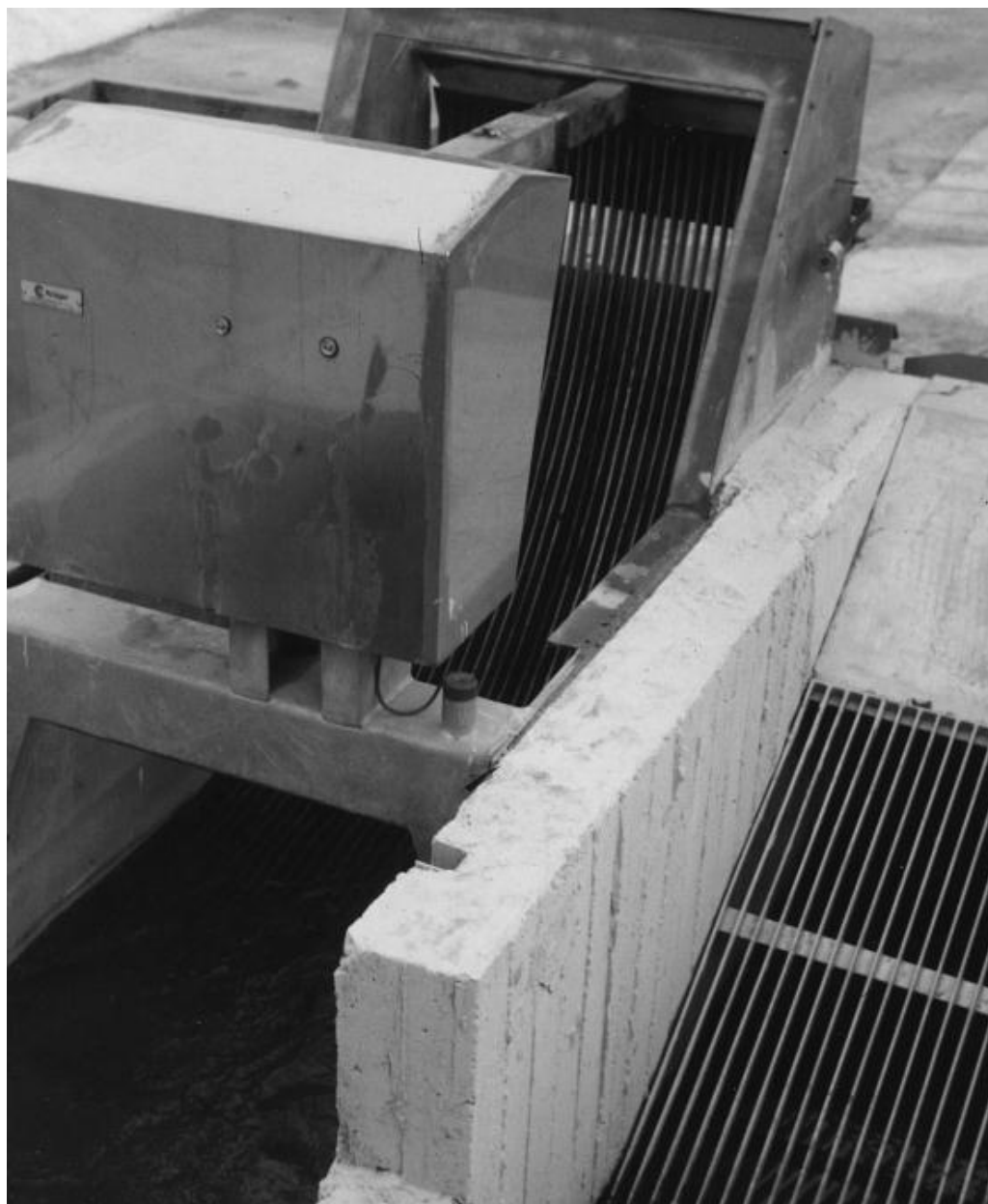
Maskinelt renseset (bagest). I forgrunden ses risten for overløb under regn
