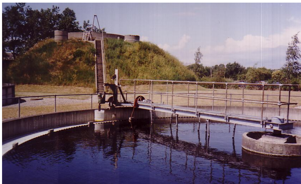
Opvarmet græsbeplantet rådnetank. I forgrunden sekundær bundfældningstank
