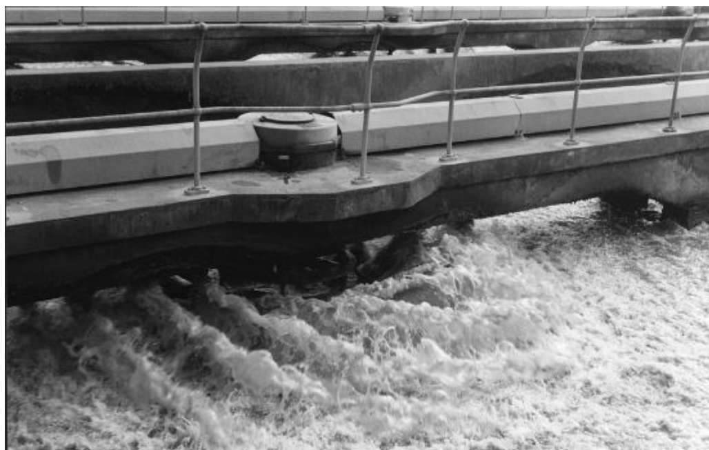
Figur 5.5 Overfladelufter. Der bliver spredt små spildevandspartikler (aerosoler) omkring aggregatet. Aerosoler er smittefarlige og kan blive ført uden for rensningsanlægget med vinden
