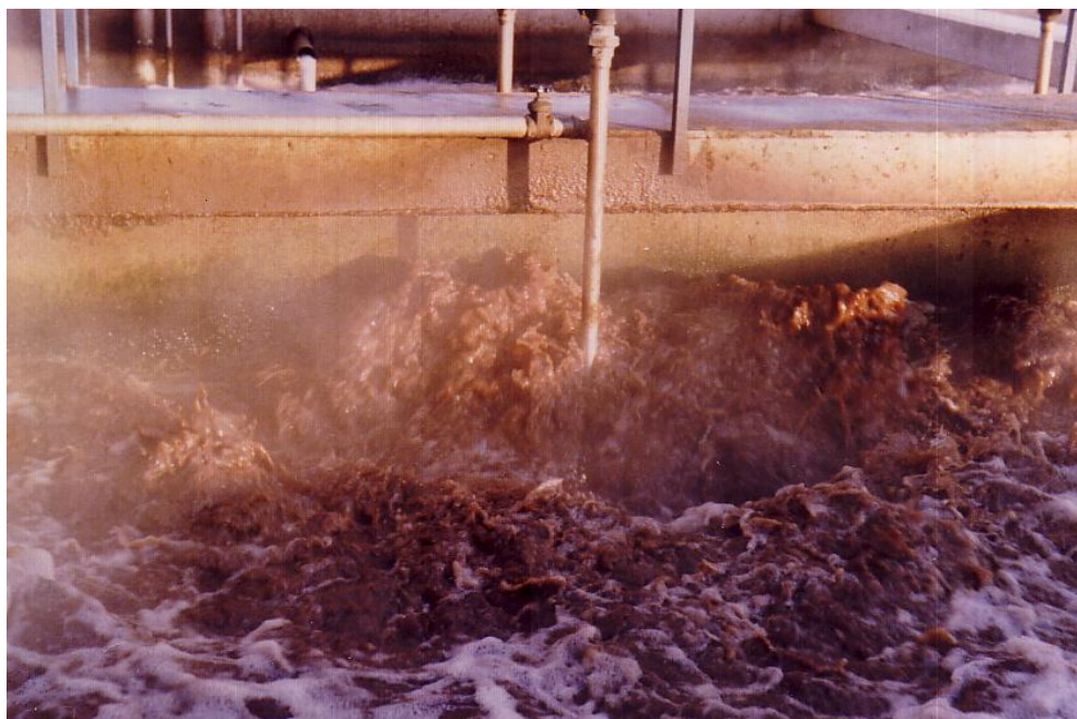
Her danner luftningen alt for mange smittefarlige aerosoler. Samtidig bruges der alt for meget energi, og en eventuel simultan denitrifikation hindres
