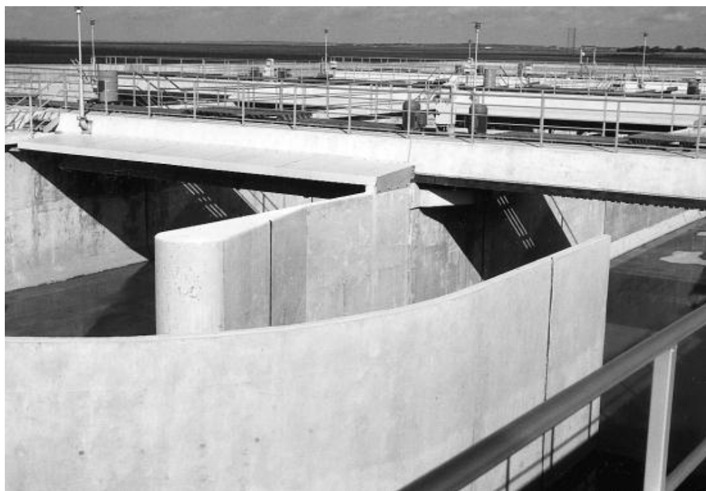
Luftningstank af ringkanaltype. Tanken er under bygning
