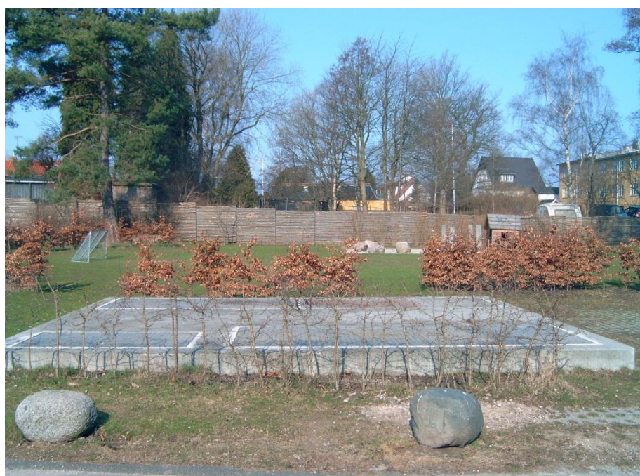
Eksempel på lukket bassin. Forsyning Helsingør A/S (vakuumslylebassin).
