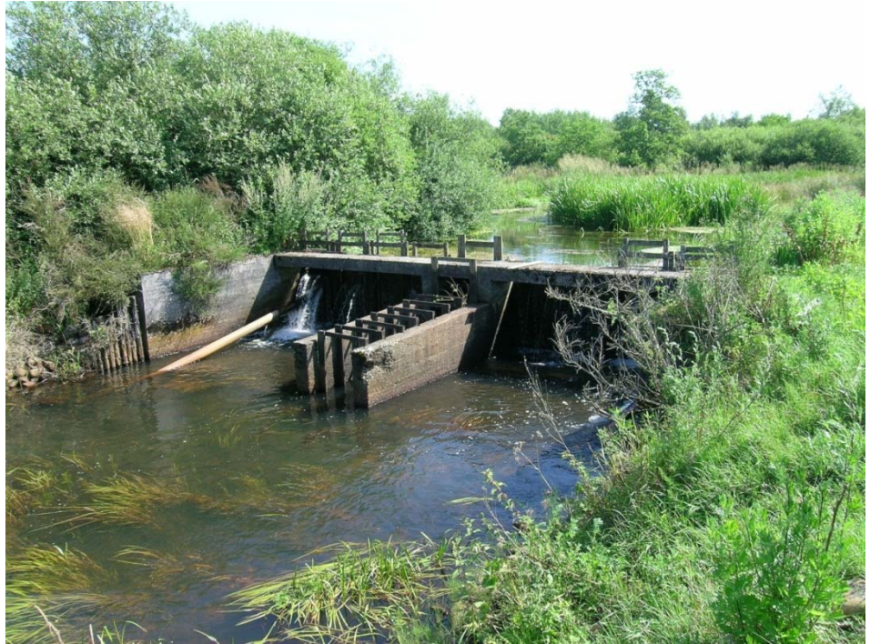
Figur 1.9. Opstemning med fisketrappe i midten ved dambrug. Næsten alt vand føres ind på dambruget
