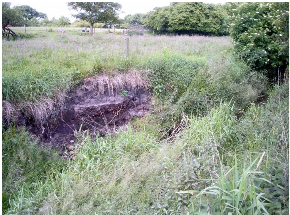
Figur 1.10. Et regnvandudløb på denne side af vandløbet har eroderet i brinken over for udløbet (Foto Sønderjyllands Amt)
